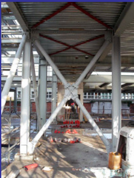
Strutture leggere in acciaio
