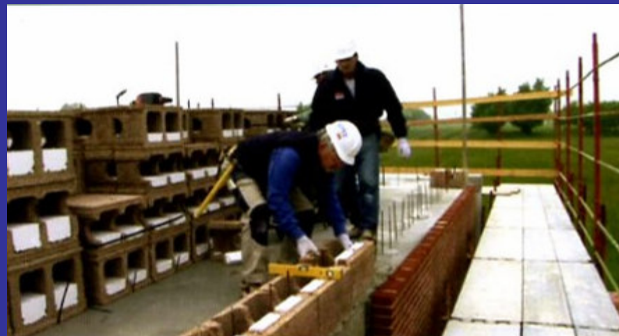
Pareti continue in blocchi-cassero armate
