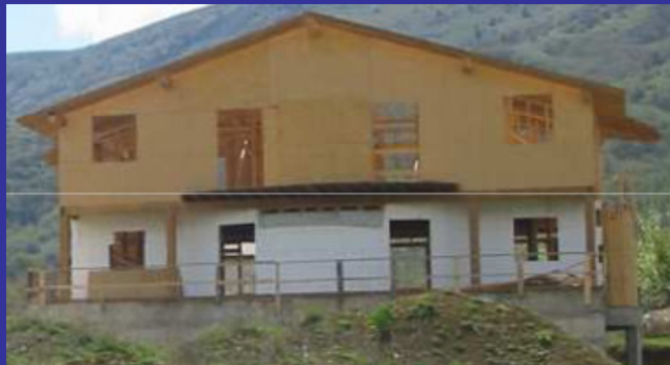
Strutture in legno a pannelli
