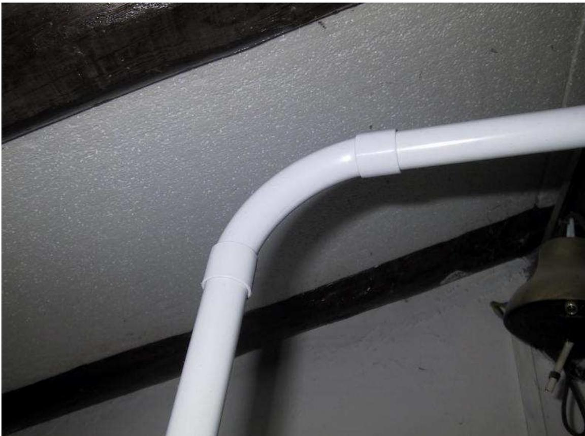
Accertatevi di avere fatto un buon lavoro e che il quadrato non sia sbilenco, ma ancora non fissate nulla in modo definitivo, potreste dover aprire qualche giunta per facilitare il passaggio dei cavi. A questo punto inserite il cavo a 8 conduttori, facendo in modo che nel percorrere il quadrato esso
